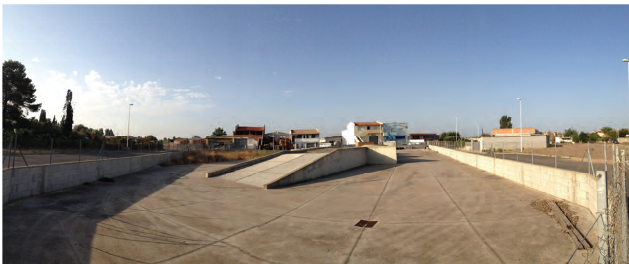
Panoramica interna lato EST
