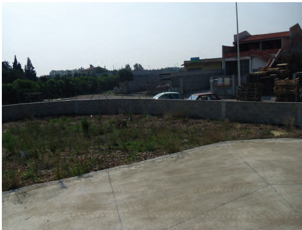
Particolare porzione non pavimentata
