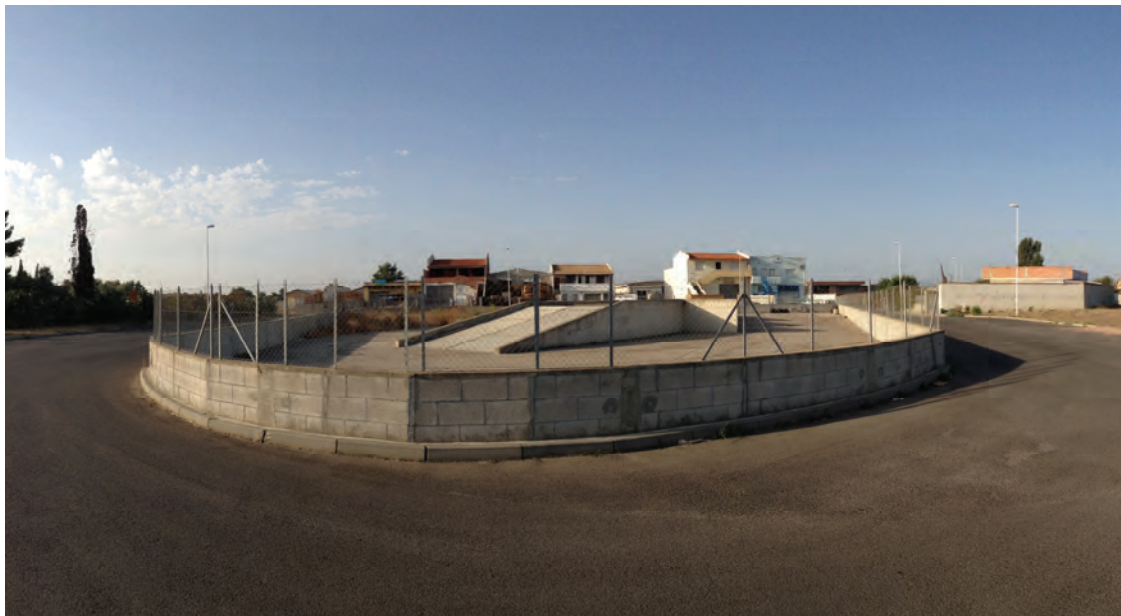
Panoramica esterna lato EST
