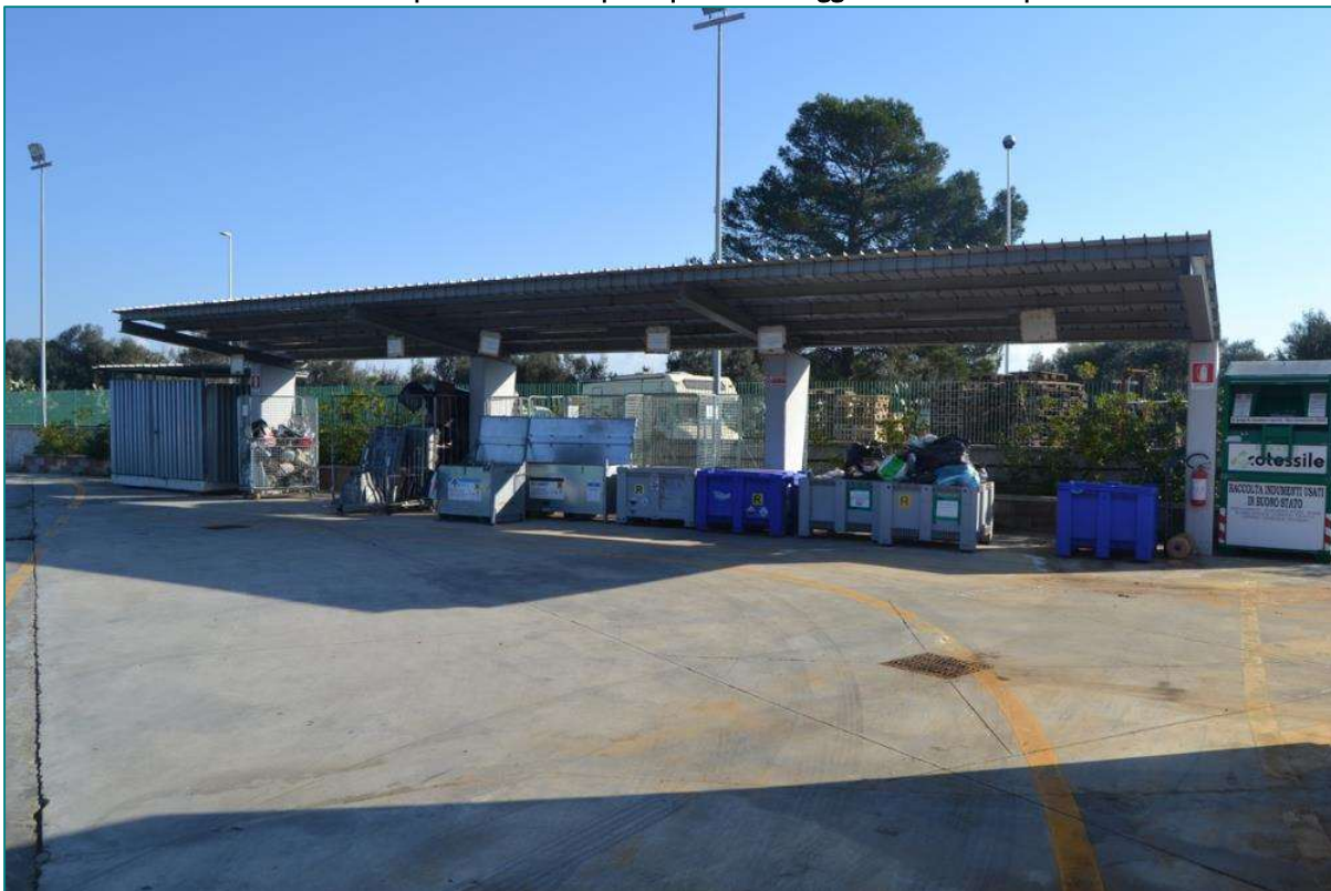
Ecocentro del Comune di San Sperate – foto dal piano rialzato in direzione ingresso della struttura
