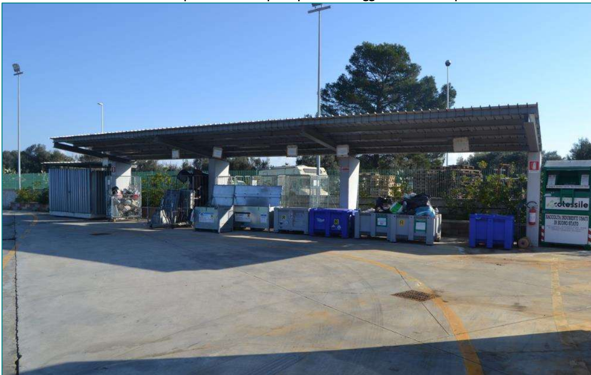
Ecocentro del Comune di San Sperate – area coperta per lo stoccaggio dei materiali pericolosi come i RAEE
