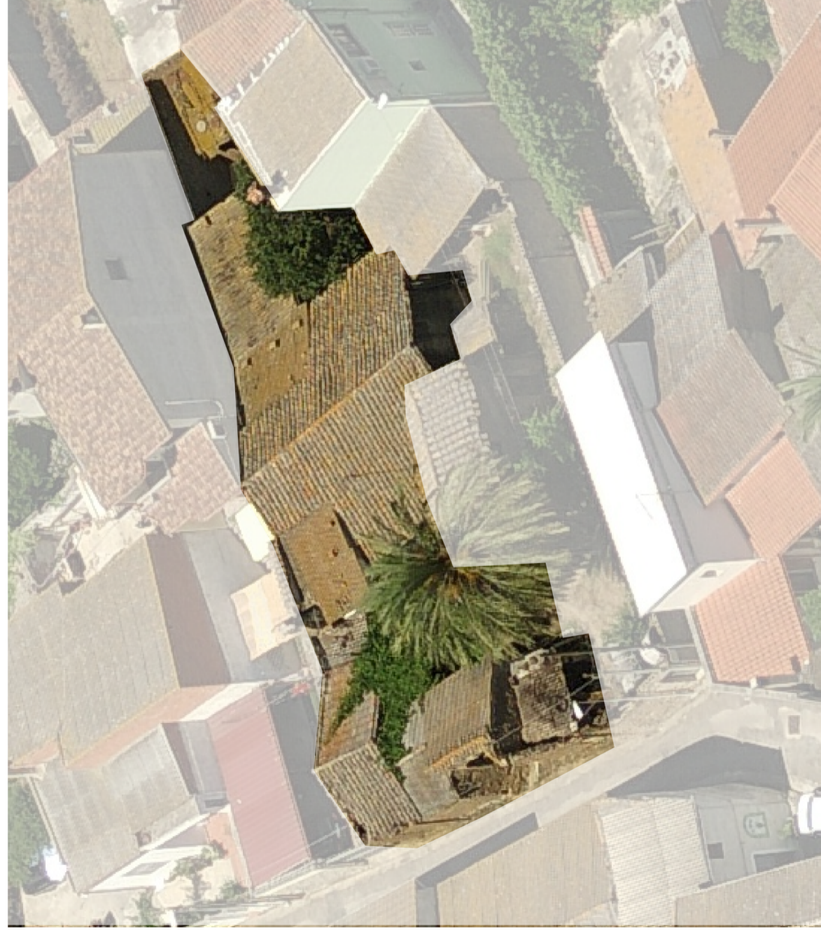
Foto obliqua stato attuale
