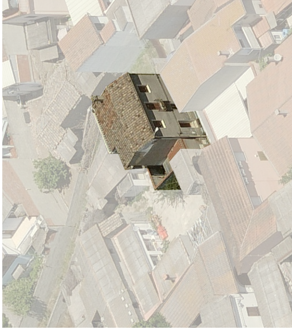
Foto obliqua stato attuale
